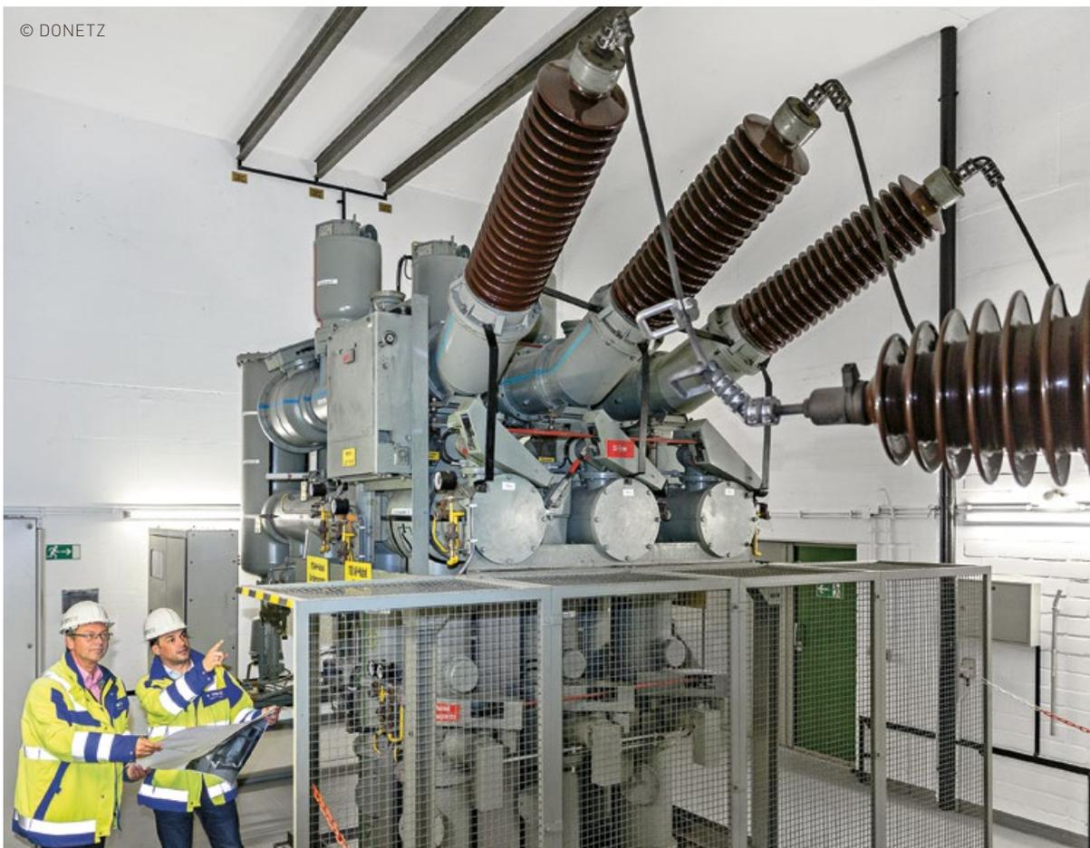
**Reserven realisieren:** Für konstant hohe Versorgungssicherheit während des GIS-Umbaus in der Umspannanlage Kronenburgallee planen die DONETZ-Anlagenspezialisten Jörg Sprinck (links) und Andreas Liese (rechts) eine direkte Transformatoranbindung ans 110-kV-Netz mittels einer Baueinsatzlösung von PFISTERER.
