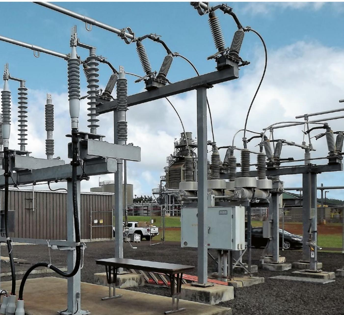
**Betriebssichere und ressourcenschonende Stromversorgung:** Innerhalb des Umspannwerkes sind drei selbsttragende trockene Kabelendverschlüsse über das Schaltwerk mit der Freileitung verbunden.
