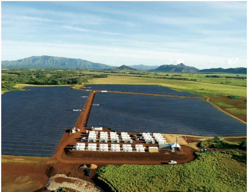
**Zukunftsweisendes Projekt:** Auf der hawaiianischen Insel Kauai entsteht auf einer Fläche von 26 ha der erste Solarpark mit Powerpacks von Tesla, die Solarstrom zwischenspeichern.
