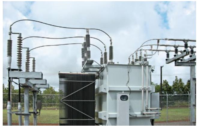
**Öl- und gasfreie Feststoffisolierung:** Außerhalb des Umspannwerkes verbinden die IXOSIL Endverschlüsse das Kabel mit dem Transformator.
