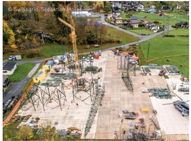
**Test vor dem Flug:** Auf einem Vormontageplatz bei Salvan erproben die Montageunternehmen mit einem Kran die Luftwegtransporttauglichkeit der vormontierten Mastetagen, bevor sie per Helikopter zum Maststandort geflogen werden.
