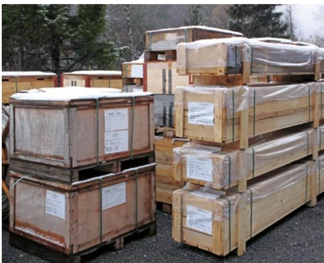
**Detailgenaue Leistung für durchdachte Logistik:** Die Kettenarmaturen (links) und 380-kV-Isolatoren (rechts) liefert PFISTERER abgepackt pro Mast – gemäß Anforderung von Swissgrid für montagefreundliche Materialbereitstellung.
