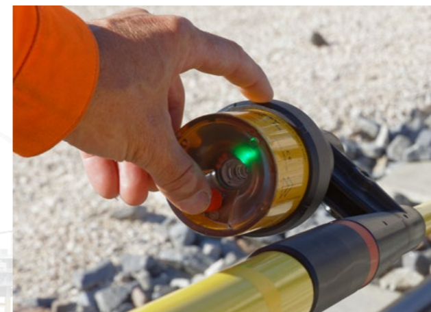
Direkte Rückmeldung vom Spannungsprüfer beim aktiven Einschalten
