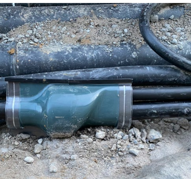
Kabelabzweig mit Gießharzmuffe AM130/300 ausgegossen mit FILLBRH
