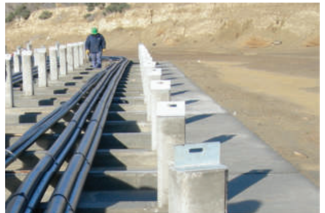
Edenor S.A. S.E. Aniversario Construcción y Montaje de Tanque de Incendio. Pipping sistema de incendio Construction and Assembly of Fire Tank. Pipping fire system
