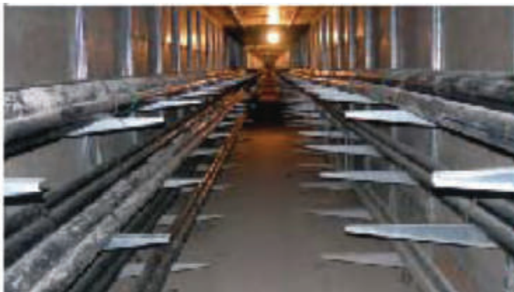
Edenor S.A. Construcción y Montaje de Soportes de cables de 13,2 kV Edenor S.A. Construction and Assembly of 13.2 kV Cable Supports
