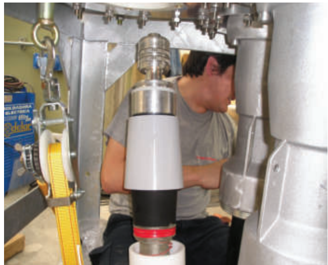
Edelap S.A. S.E. Rocha Conexionado de GIS Hyundai 132 kV - GIS connection
