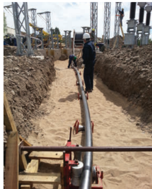
Transener S.E. Planicie Banderita Tendido y Conexionado de Cable Subterráneo de 132 kV installation and connection 132 kV underground cable
