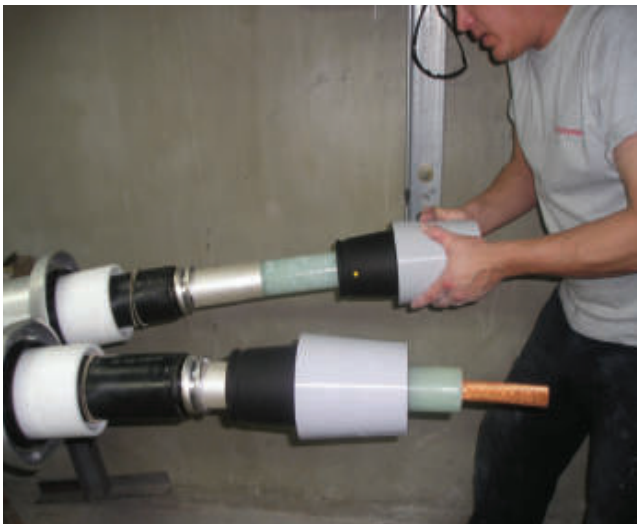
Edelap S.A. S.E. Rocha Conexionado de GIS Hyundai 132 kV - GIS connection
