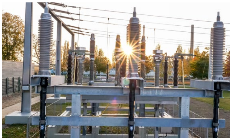
Szybki i bezpieczny – montaż w ekologicznej technologii
