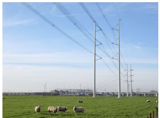
Pays-Bas: Le système Wintrack de TenneT réduit le rayonnement électromagnétique de 60%.
