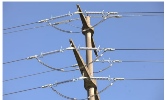
Suisse: Chaînes de suspension compactées
