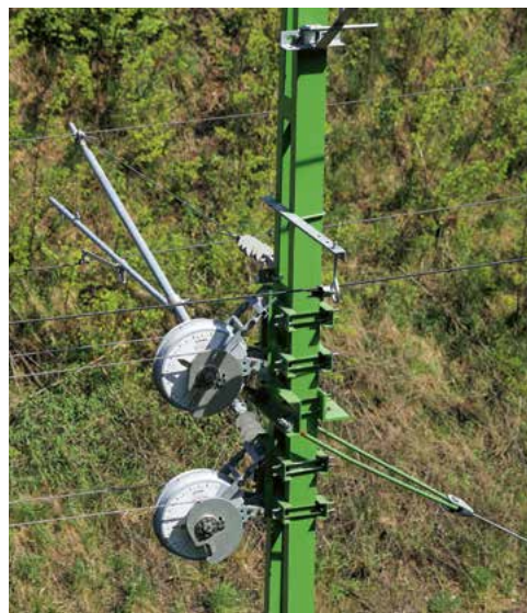
Das kompakte Federnachspannsystem TENSOREX C+ ist die moderne Alternative zu herkömmlichen Radspannsystemen.
