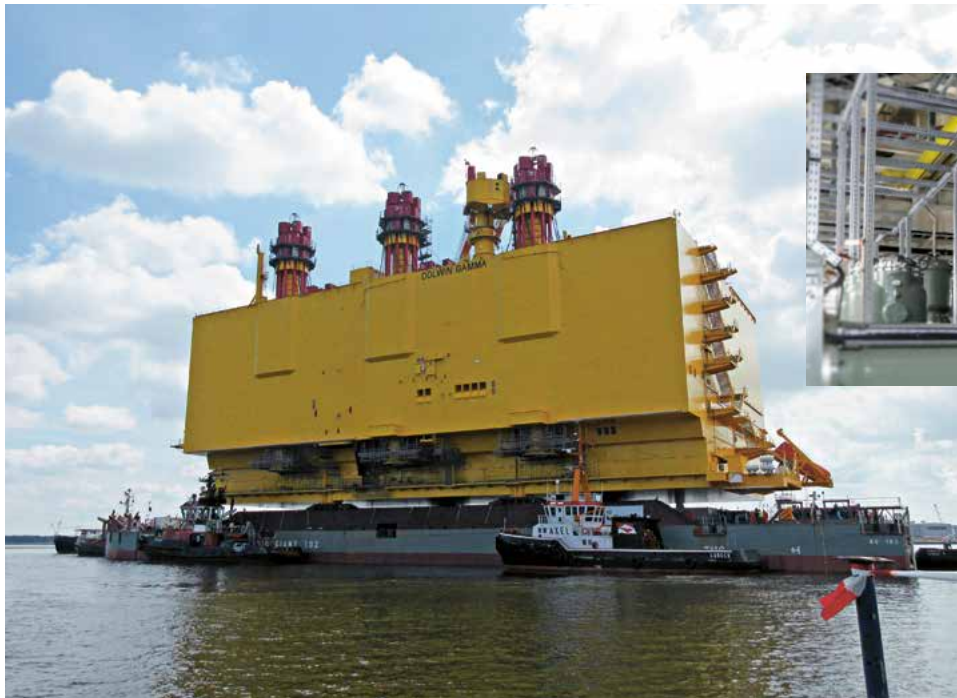
Offshore-Plattform DolWin gamma beim Ausschiffen in Warnemünde im Juni 2017. Hier wurden erstmals hochflexible 155-kV-Kabel mit steckbaren CONNEX Anschlussgarnituren installiert.
