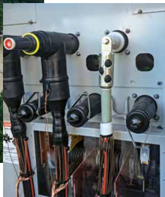
Für jede Anwendung der richtige SICON Verbinder. Hier als Kontaktelement im Außenkonusstecker.
