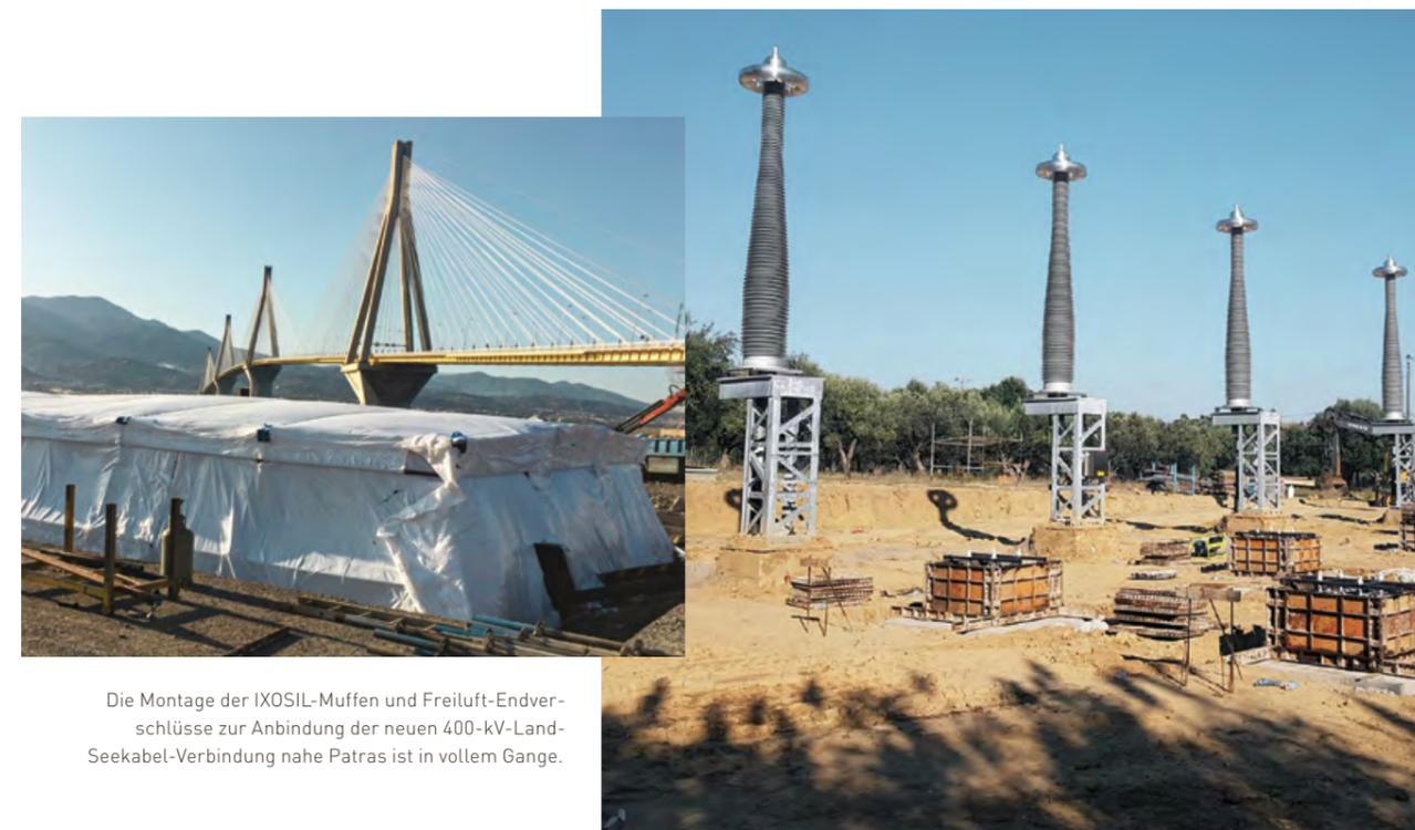
Die Montage der IXOSIL-Muffen und Freiluft-Endverschlüsse zur Anbindung der neuen 400-kV-Land-Seekabel-Verbindung nahe Patras ist in vollem Gange.
