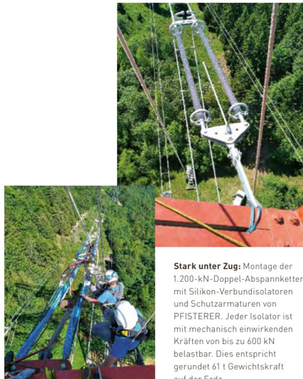
**Stark unter Zug:** Montage der 1.200-kN-Doppel-Abspannketten mit Silikon-Verbundisolatoren und Schutzarmaturen von PFISTERER. Jeder Isolator ist mit mechanisch einwirkenden Kräften von bis zu 600 kN belastbar. Dies entspricht gerundet 61 t Gewichtskraft auf der Erde.
