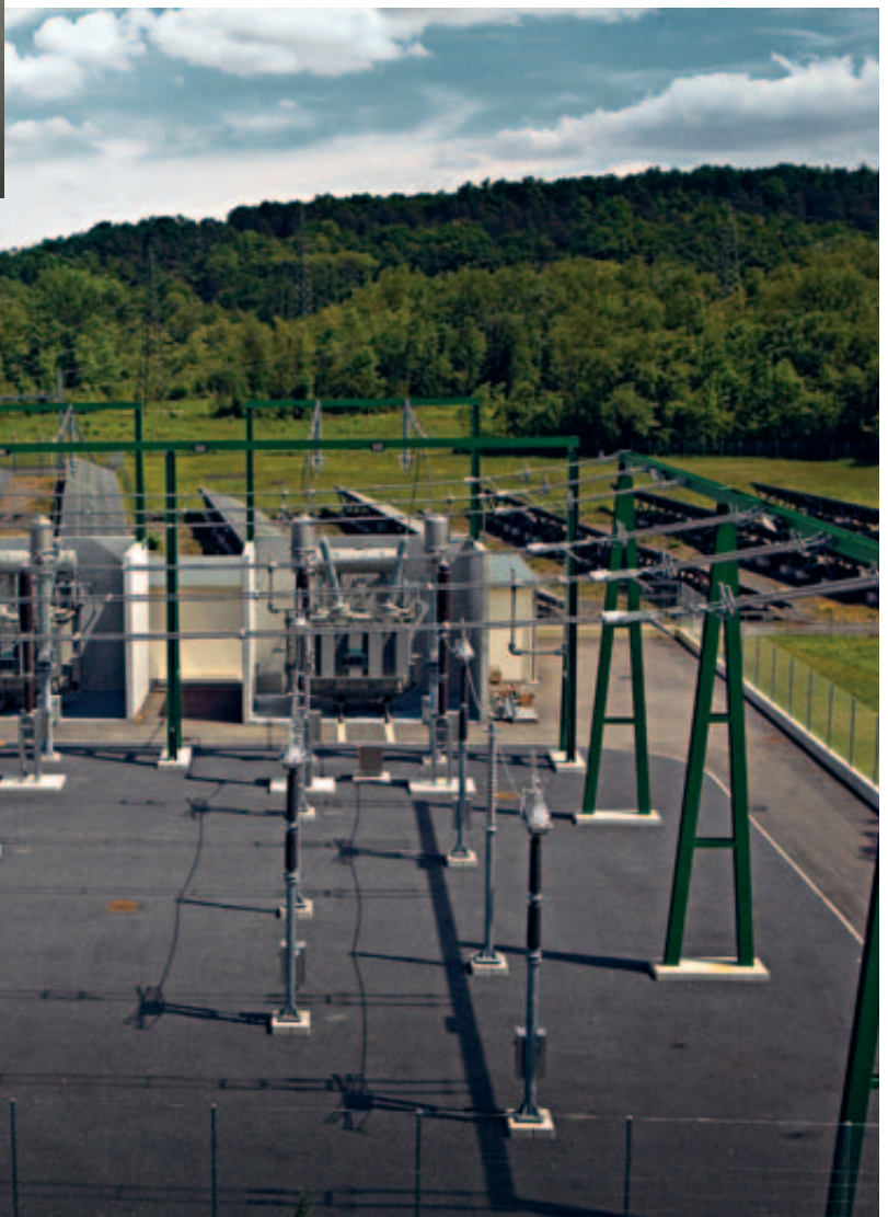
Für den Anschluss der neuen Transformatoren an die Stromwandler (kleines Bild links oben) wurden Abspannketten und FSK-Klemmen von PFISTERER eingesetzt.
