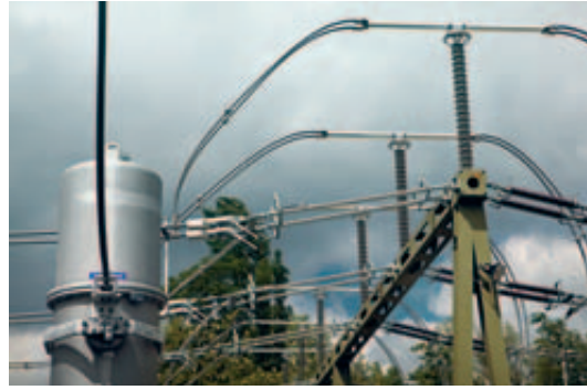
Montage von PFISTERER-Produkten am Übergang vom neuen Umspannwerk Verbois zum bestehenden 245-kV-Umspannwerk (linkes Bild) und nach ihrer Installation (rechtes Bild): Isolationsstützer stehend auf dem Portal, davon waagrecht abgehend nach links die hochbelastbaren Abspannketten.
