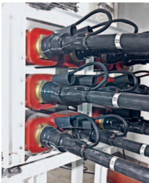
Erprobter Vorgänger: CONNEX-Verbindungs-muffen der Größe 3 sind auf hoher See bereits im Einsatz, wie beispielsweise hier auf einer Offshore-Umspannstation.
