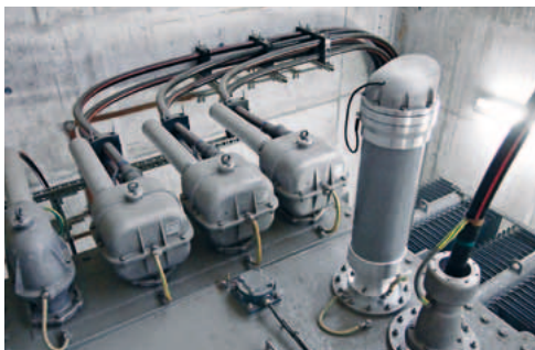
Ideal für Innenraum: CONNEX-Ableiter und -Kabelanschlüsse der Größe 3 (links) und 4 (rechts) am Transformator
