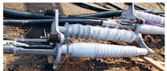
Bereit für die schnelle Installation am Mast: EST-Endverschlüsse nach ihrer Vormontage in einem wettergeschützten Container
