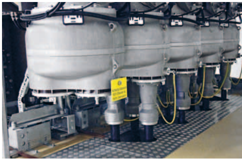
Konsequent eingesetzt im UW Klus: CONNEX-Komponenten für rundum steckbare und berührungssichere GIS
