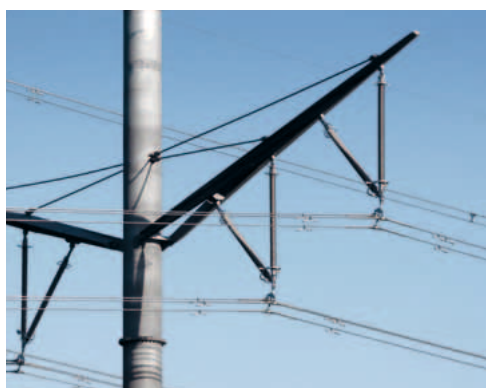
Nur mit Silikon-Langstab-Verbundisolatoren realisierbar: Kompakte und druckbelastbare V-Tragketten
