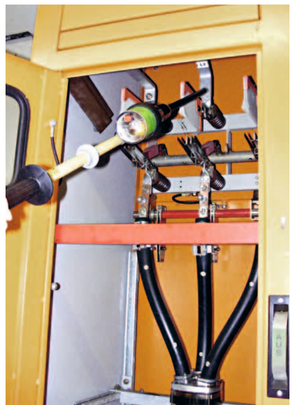
Verhindert Schadensfälle: Prüfung der Phasenlagen, bevor Komponenten zusammengeschlossen werden
