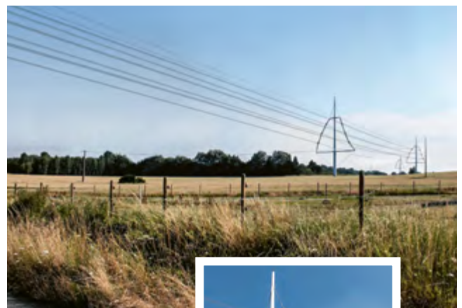
Das besondere Mastdesign orientiert sich mit seiner Segelform an den typischen Merkmalen der Küstenregion.
