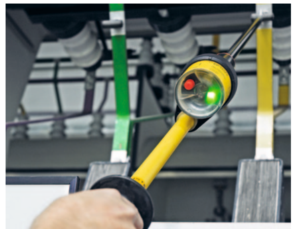
Spannungsprüfer KP-Test 5 gibt grünes Licht für Wartungsarbeiten.
