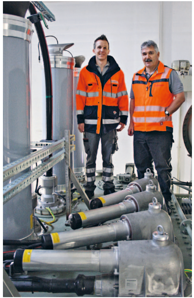
Montage-Freundlichkeit trifft Montage-Erfahrung: Die PFISTERER-Monteure Peter Barmettler (links) und Heiri Bissig (rechts) installierten vier von insgesamt acht CONNEX-HV-Überspannungsableitern 5-S in jeweils neun Stunden. Vorne im Bild zu sehen: Mit CONNEX-Mehrfach-Winkelanschlussstellen lassen sich Mittelspannungskabel und -Ableiter direkt nebeneinander installieren und dabei waagrecht ausrichten. So spart man nicht nur Bauraum, sondern kann auch zur Einhaltung von Anlagengrenzwerten kritische Feldlinien nahe an der Anlage entlangführen.
