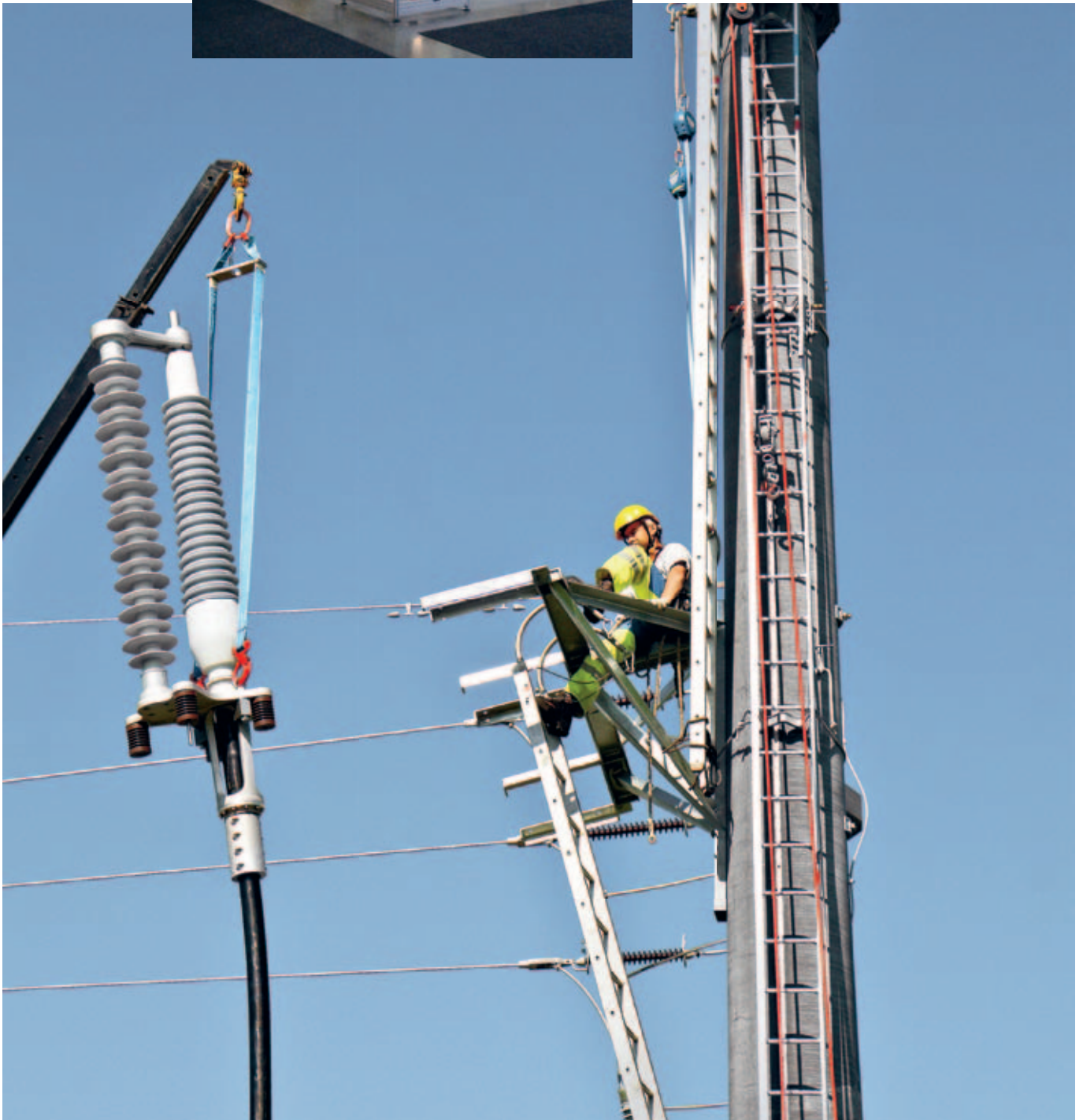
Innovativer Endverschluss EST im Einsatz an einer Freileitung (Bild unten)
