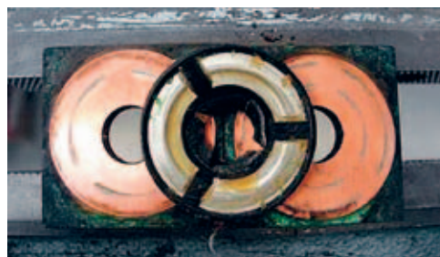
PFISTERER-Kontaktscheiben für definierte Kontaktflächen
