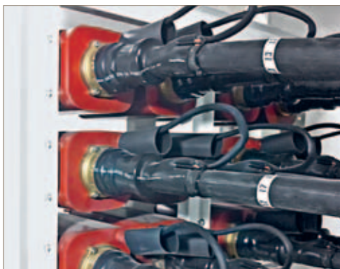
Seetaugliche Schnittstelle: MV-CONNEX-Muffen sind waagrecht und senkrecht montierbar
