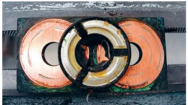
PFISTERER-Kontaktscheiben für definierte Kontaktflächen
