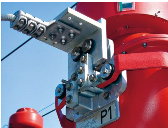
Schutz vor Korrosion: Al-Elastkontaktscheibe von PFISTERER schließt Kontaktstellen hermetisch ab
