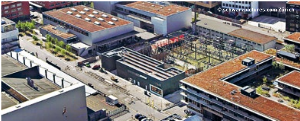
Smart gespart: Das neue ewz-Umspannwerk Oerlikon wurde im Stadtgebiet von Zürich errichtet und befindet sich auf drei unterirdischen Ebenen direkt unter einem ebenfalls neuen ewz-Netzstützpunkt (Bildmitte). Zusammen beanspruchen die Bauten sichtbar weniger Fläche als die alte Freiluft-Schaltanlage des Vorgänger-Umspannwerks (hinter dem Neubau) allein.
