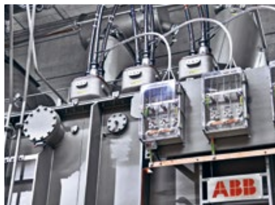
Hochkompakt aus einer Hand: Die neuen CONNEX-Transformatoren-Anschlusssteile (TAT) der Größe 3 für bis zu 52 kV von PFISTERER ermöglichen den Mehrfach-Anschluss von vertikal geführten MV-Kabeln. Die jüngsten Neuzugänge im bewährten CONNEX-System sind im Umspannwerk Oerlikon erstmalig im Einsatz – im Verbund mit Erdtrennerkästen und DSA-i3-Dauerspannungsanzeiger-Geräten.
