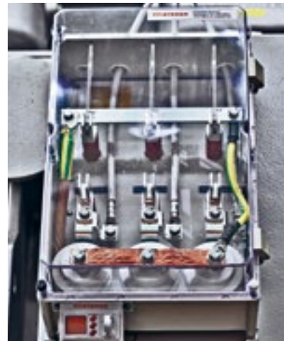
Kompakter Allrounder clever kombiniert: PFISTERER-Erdtrennerkasten gemäß EN 61439 für effiziente und betriebssichere Schirmbehandlung mit integrierter Kabelverlustoptimierung, verbunden mit einem DSA-i3-Dauerspannungsanzeiger von PFISTERER nach IEC 61243-5 (VDS-Prüfsysteme) als permanent sichtbares Überwachungsmodul für das Betriebspersonal (links unten im Bild)
